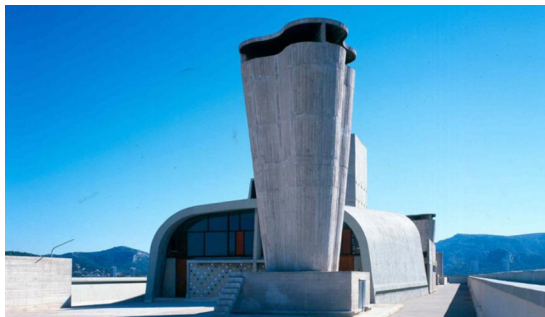
FIGURA 8 Le Corbusier, Unité d'habitation , Marsella. Chimeneas de aire viciado y pantalla de viento y escenario
