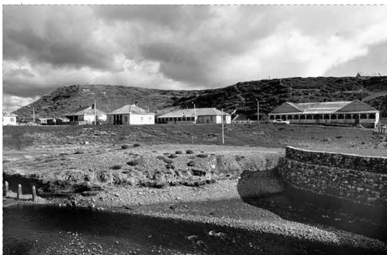
Vista de casco en estancia Cameron (Seff) (fuente: Piwonka, 2003).
